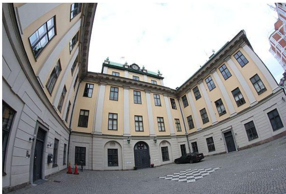
Figure 11 Vue depuis la cour. L'entrée se fait par le secrétariat situé au niveau de la porte à gauche.
